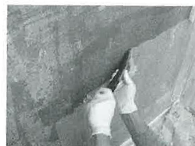
▲コンクリート面の下紙剥がしは、たっぷりと水を与えてふやかすのがコツです。
