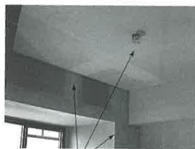
クロス用のパテが塗られているところがボードのジョイント部です。
