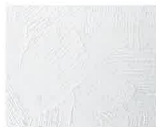
木ゴテ引きずり仕上げ(NSR)
