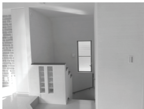
2Fリビングから階段へ続く壁に施工されたNZ-1Nほうき引きヘッドカット仕上げ
