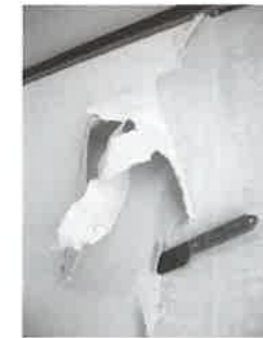
▲ニオイが出たため、下塗りした壁を剥がすことになった現場
