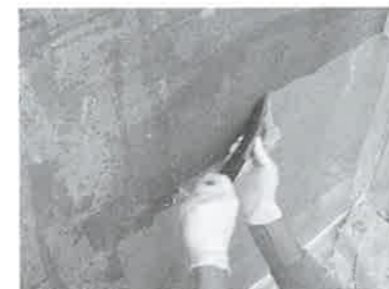
▲コンクリート面の下紙剥がしは、たっぷり水を与えてふやかすのがコツです。
